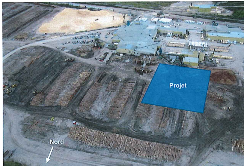
Figure 2-3 : Vue aérienne - Localisation du projet
