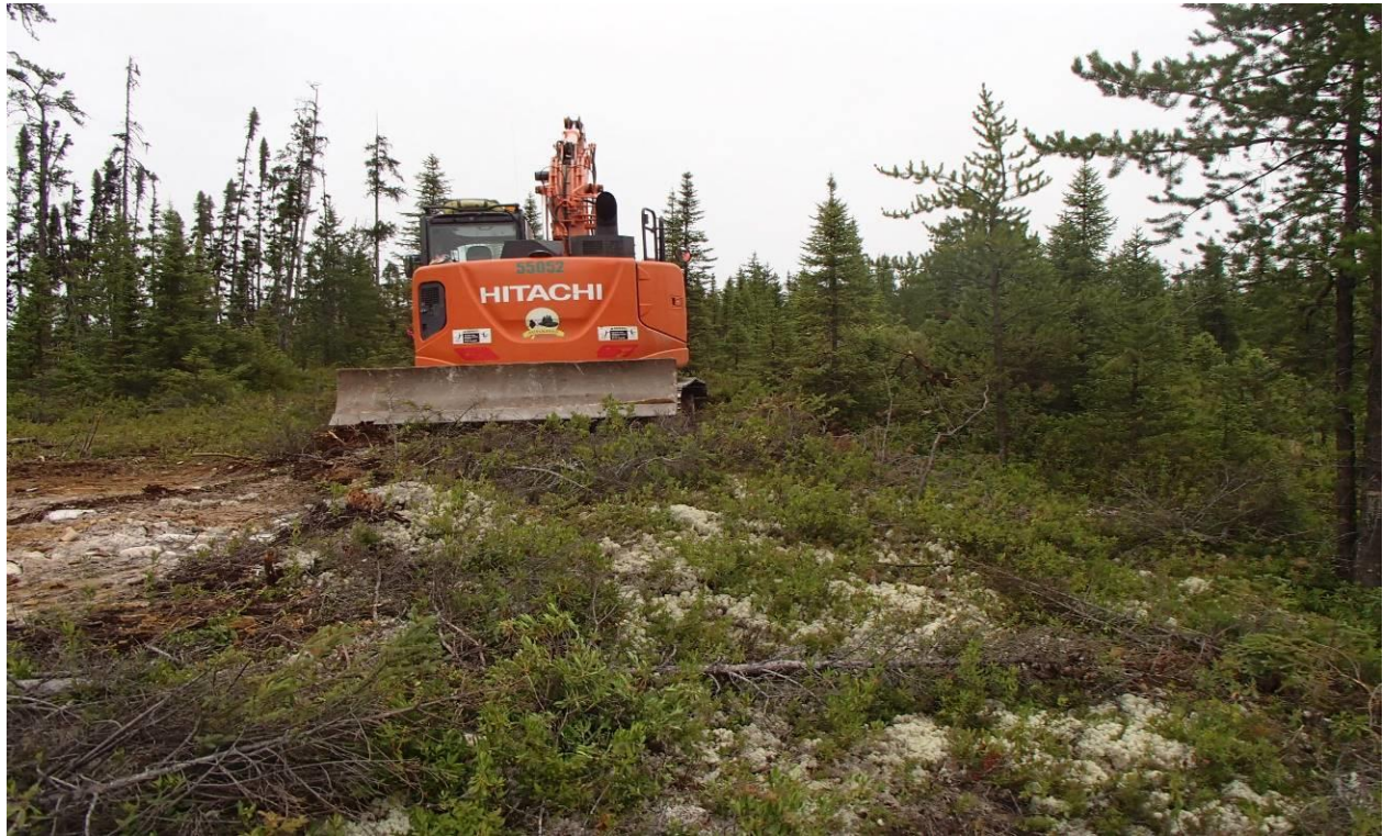
Photo 10 : Préparation du terrain avant la réalisation de la tranchée AHS-TR01
