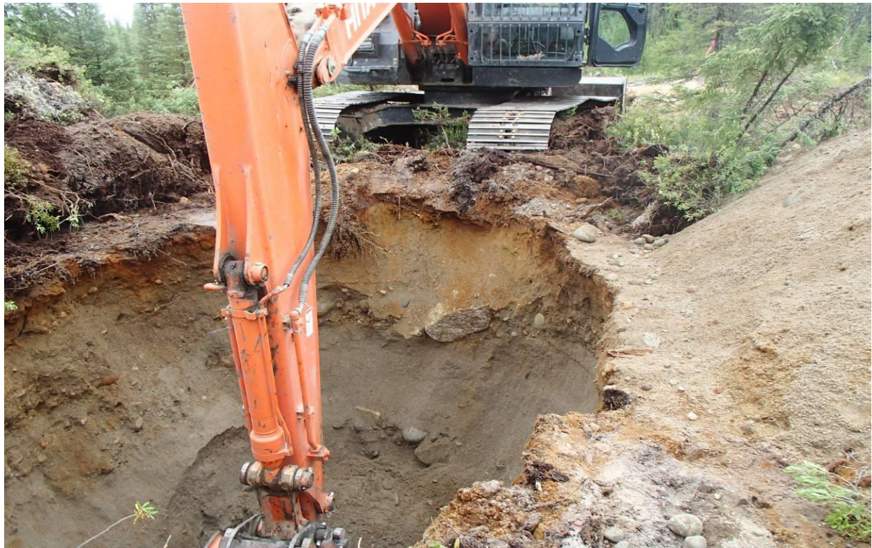
Photo 11 : Réalisation de la tranchée AHS-TR01-21
