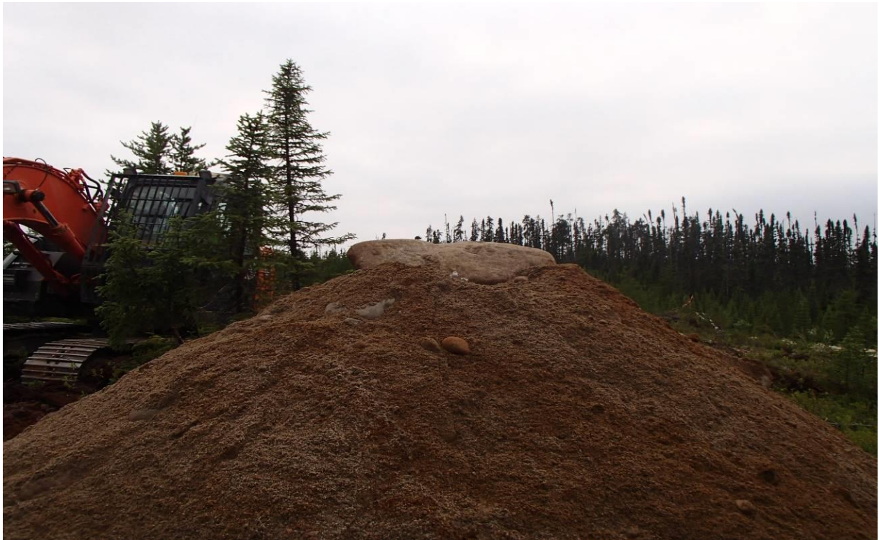
Photo 12 : Déblais de la tranchée d'exploration AHS-TR01-21
