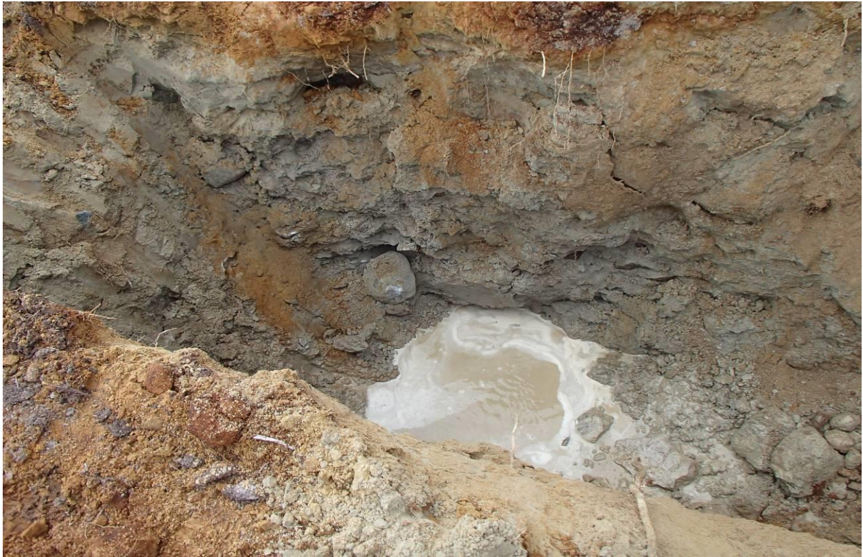
Photo 12 : Venue d'eau lors de la réalisation de la tranchée d'exploration HMTN-TR02
