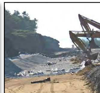
IMPERMÉABILISATION DE FOSSE
