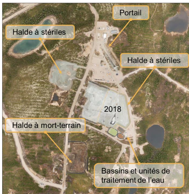
Figure 1-2 Photographie aérienne du site Windfall après les activités du premier échantillon en vrac
