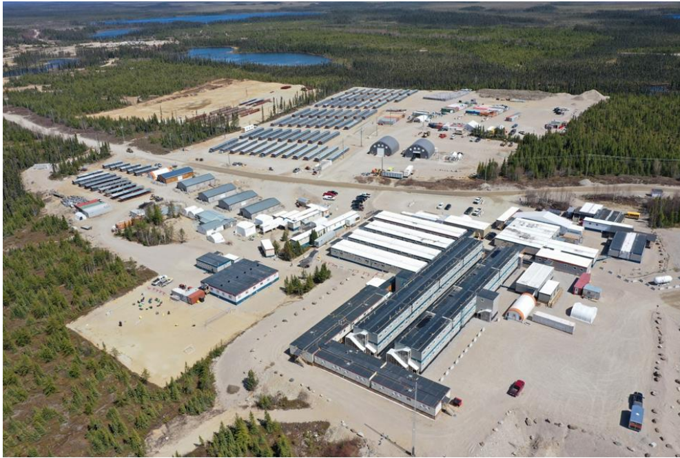
Figure 1-4 Image de drone du secteur du campement d'exploration, 2021
