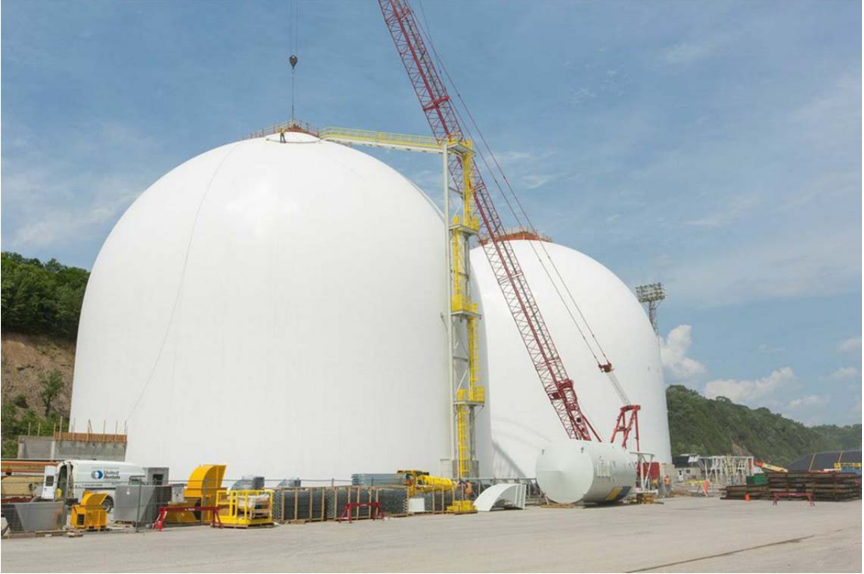
Silos construits au Port de Québec spécialement pour l'exportation de granules de bois
